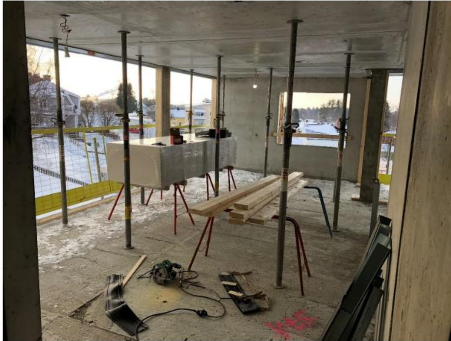
Figur E.9. Vy från byggarbetsplats med säkerhetsstämp
