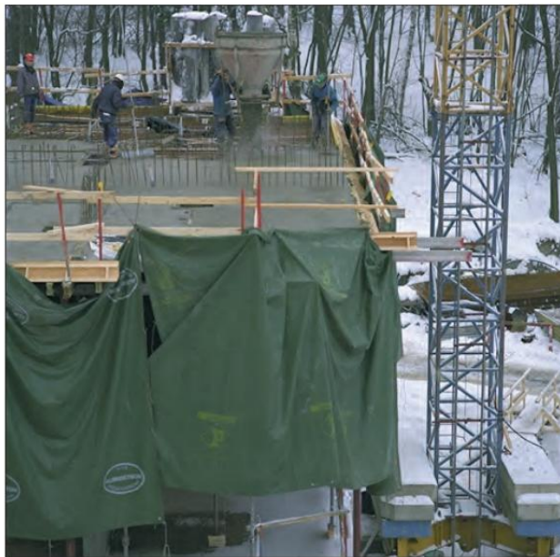
Figur B.16. Lämpliga vinteråtgärder och exempel på intäckning plan, från Vinterbetong (1999) [18]
